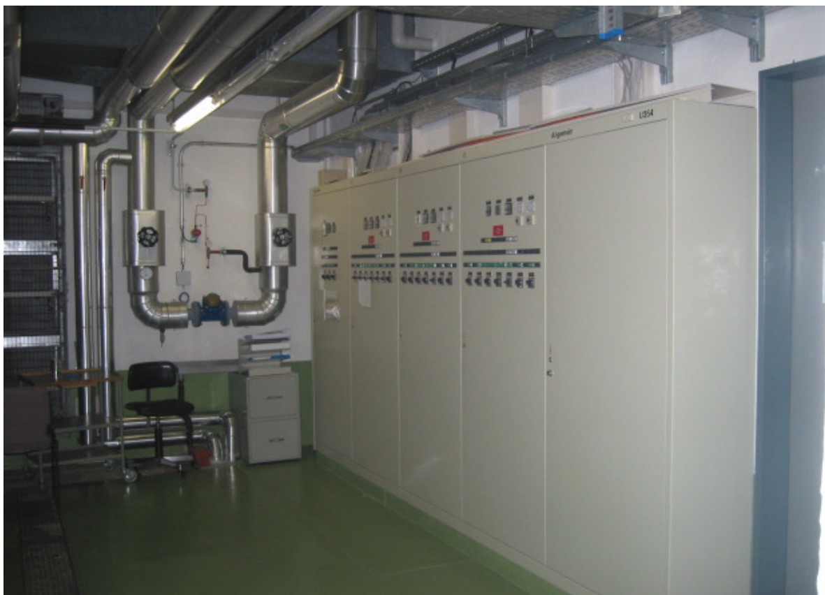
Schaltgeräte- Kombination bestehende Kälteversorgung
